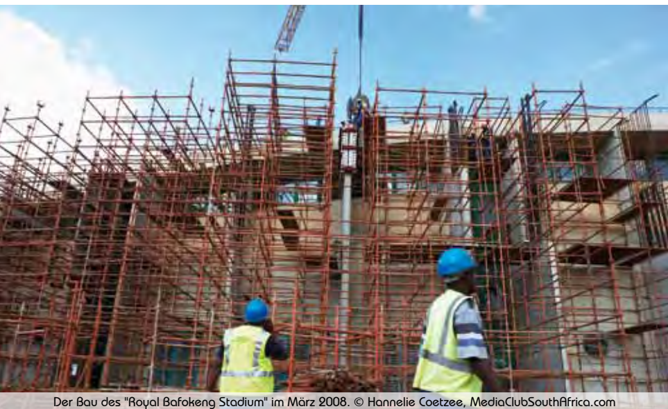
Der Bau des "Royal Bafokeng Stadium" im März 2008. © Hannelie Coetzee, MediaClubSouthAfrica.com
