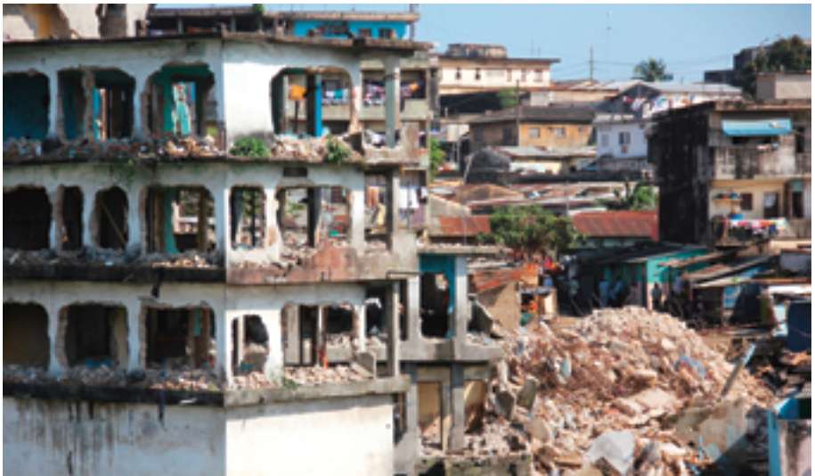
Eingestürztes Haus in einem Arbeiterviertel in Abidjan: Vom wirtschaftlichen Aufschwung in der Côte d'Ivoire unter Präsident Ouattara profitieren nicht alle gleichermaßen. Das Wohlstandsgefälle ist auch in Abidjan deutlich sichtbar. | Quelle: © Cyrille Bah, picture alliance/Anadolu Agency.
