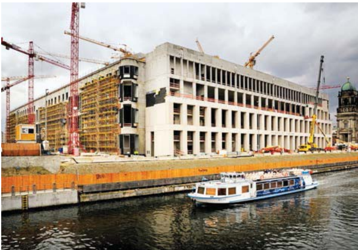
„Wiederaufbau des Berliner Stadtschlusses“: Im Bau befindliche Westfassade; in den unteren Geschossen wird das Ziegelmauerwerk den Betonwänden vorgeblendet und die Bauplastik aus Naturstein angebracht (oben). Ostfassade zur Spree hin (unten). Im fertiggestellten Gebäude wird das Humboldt Forum untergebracht. © Kitty Kleist-Heinrich / Der Tagesspiegel
