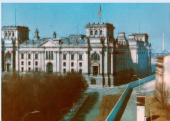
Mauerverlauf im heutigen Parlamentsviertel – heutige Ebertstraße vorbei an der Ostseite des Reichstagsgebäudes, Berlin 1989
