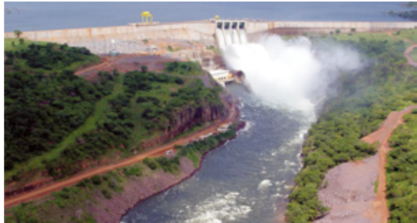
Der Capanda-Staudamm am Cuanzastrom in der Provinz Malanje erzeugt mit vier Turbinen eine Leistung von 520 Megawatt. Die Anlage deckt mehr als die Hälfte des Energiebedarfs Angolas.
