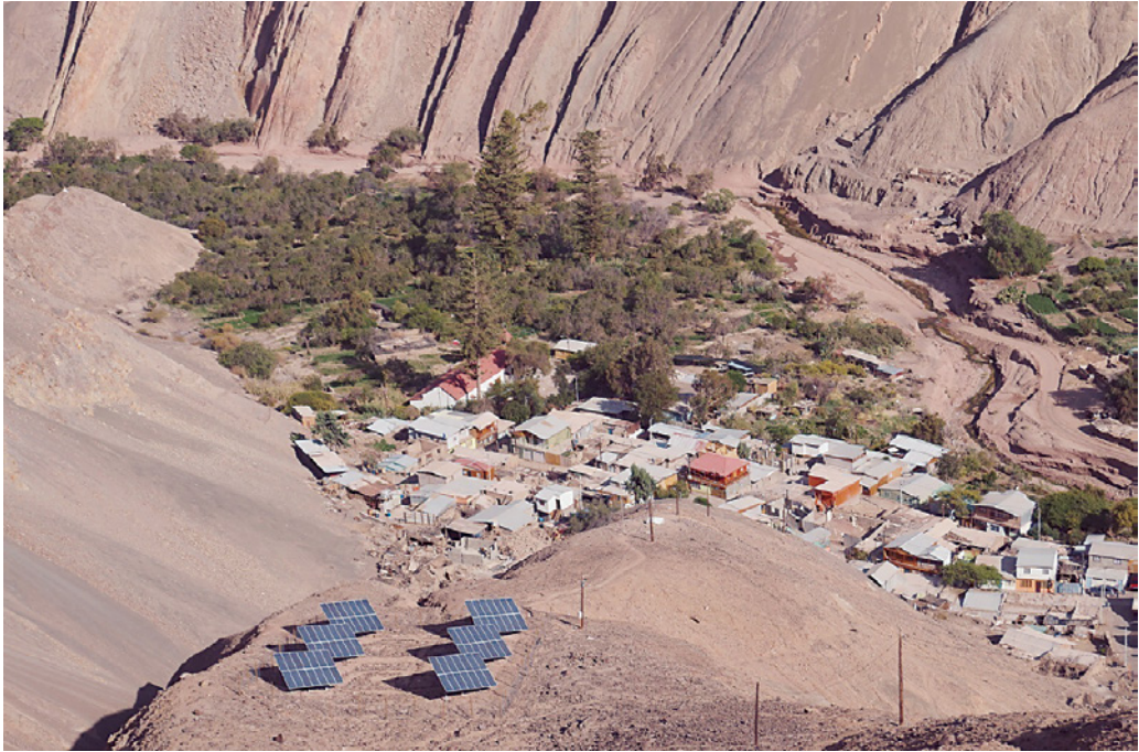
Figura 9 Instalaciones de paneles solares que forman parte de la micro-red en la comunidad de Huatacondo.
