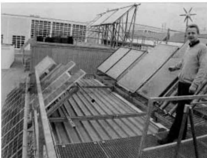
Seit fast 15 Jahren beschäftigt man sich an der Fachhochschule Bingen mit der Solarzelle. Foto: Volker zur Stromerzeugung und solarthermische Anlage zur Brauchwassererwärmung wurden in allen Verteilern getestet. Während zunächst vor allem der Ausstattungsbedarf im Winterquartier stand, legen private Solar-Nutzer heute mehr Wert auf die Kostenreduktion. Dipl.-Ing. Matthias Schwankhäuser ist bei der FH Ansprechpartner für Sachen Solarzelle, die inzwischen eher im Zusammenhang mit anderen regenerativen Energiefeldern steht. Statt einzig und allein auf Sonnenenergie zu setzen, kombinieren die FH-Fachleute zwischen der Energie-Mix und bieten optimale Management-Lösungen an. © Foto: Armin Seibert
