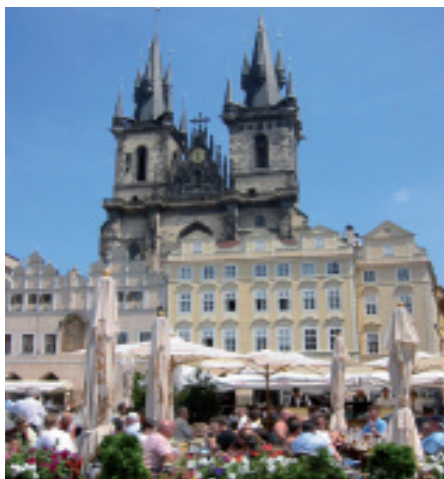
Teynkirche in Prag
