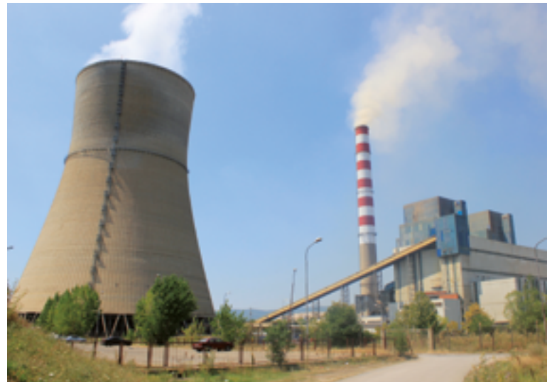
Braunkohlekraftwerk bei Obiliq. Bis 2020 will der Kosovo 26 Prozent seines Energiebedarfs durch erneuerbare Energien abdecken, bisher sind es weniger als drei Prozent.
