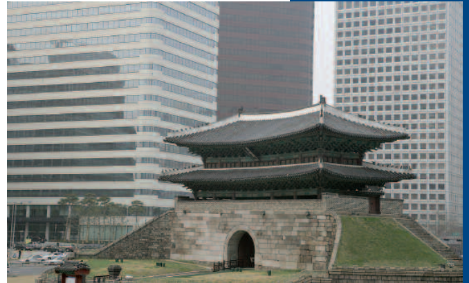
Deutliche Gegensätze: Ein altes Stadttor und moderne Bürogebäude in der südkoreanischen Hauptstadt Seoul
