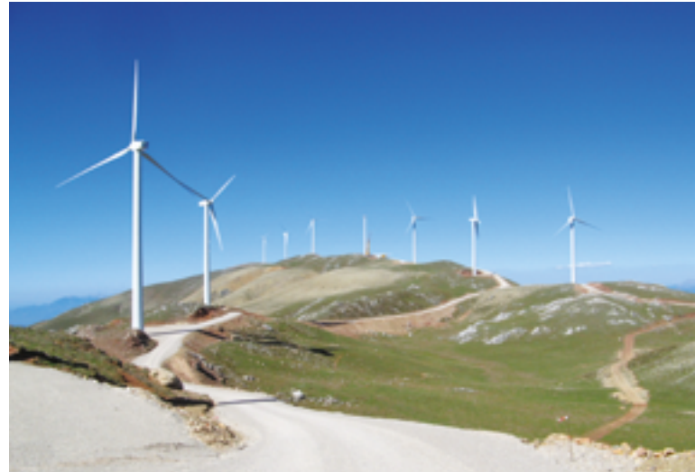
Die installierte Windkraftleistung hat sich in Griechenland seit 2008 mehr als verdoppelt. 2006 ging der mit 40 Anlagen größte Windpark des Landes im Panachaiko-Gebirge ans Netz.
