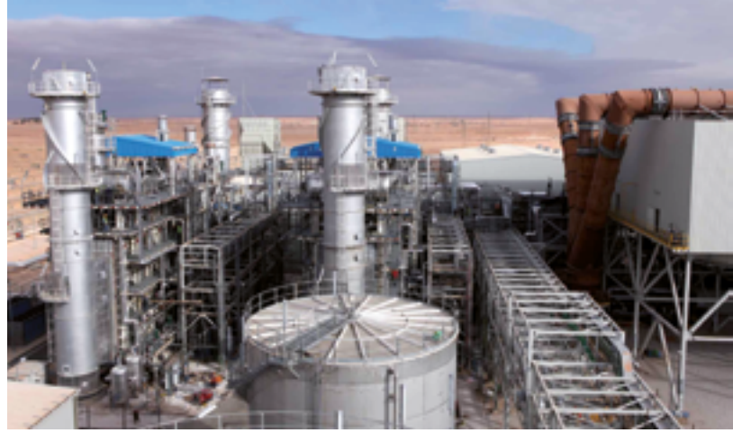
Das Hybridkraftwerk Hassi R'Mel in der algerischen Provinz Laghouat kombiniert ein solarthermisches Kraftwerk mit einem konventionellen Gas-und-Dampf-Kombikraftwerk.
