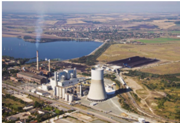
Das Kohlekraftwerk in Galabovo in der Oberthrakischen Tiefebene ist Teil des Maritza Iztok-Komplexes, dem größten Kraftwerksverbund Südosteuropas. Die Braunkohle stammt aus dem nahen Tagebaurevier im Sakar-Gebirge.
