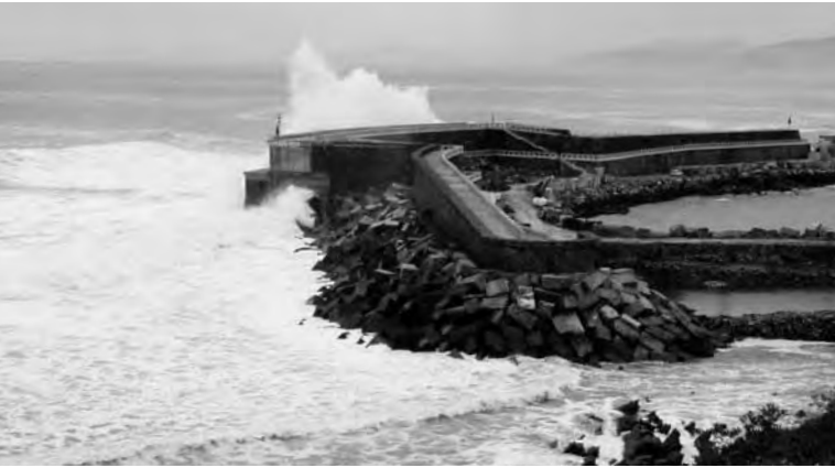
Das weltweit erste kommerziell genutzte Wellenkraftwerk ging im nordspanischen Mutriku in Betrieb. Mit der natürlichen Kraft des Wellengangs soll eine Leistung von rund 300 Kilowatt erzeugt werden, mit der bis zu 250 Haushalte versorgt werden können.
