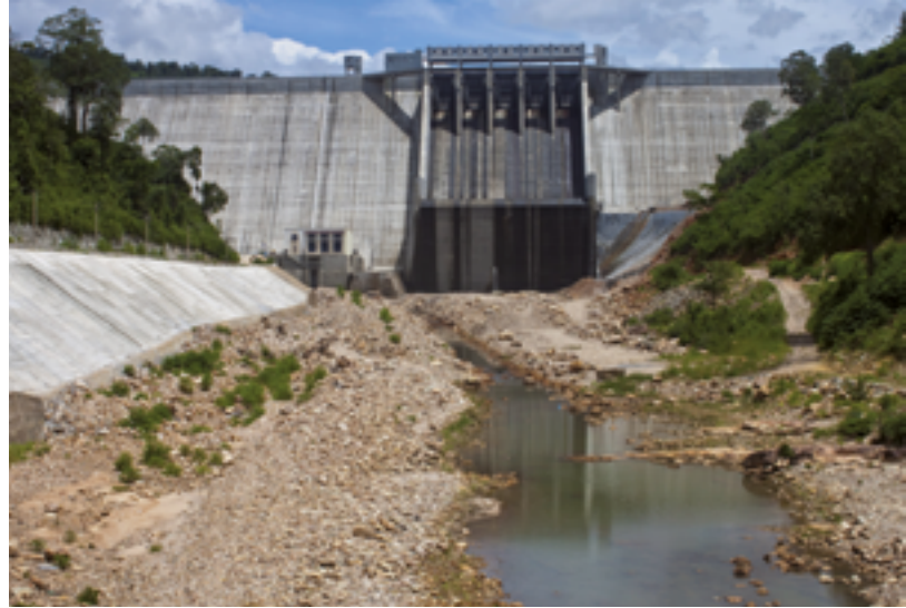
Kamchay-Staudamm bei Kampot. Wasserkraft hat einen Anteil von 3,68 Prozent an der kambodschanischen Stromproduktion.
