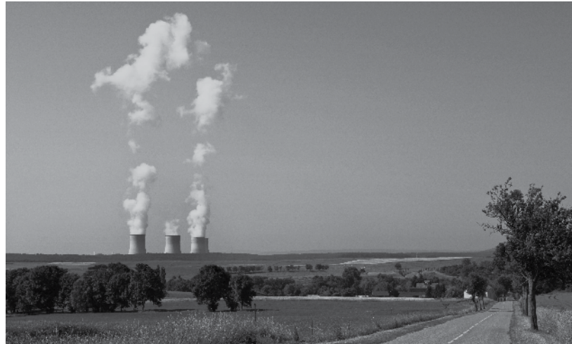
Im Kernkraftwerk im lothringischen Cattenom werden vier Druckwasserreaktoren betrieben. 2007 war der die Anlage mit 37 Terawattstunden ins Netz gespeister elektrischer Energie der größte Produzent in Frankreich.
