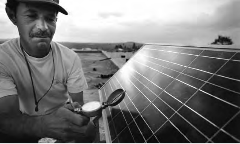
Ausrichtung eines Solarmoduls durch einen Techniker.
