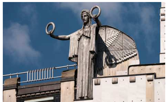
Fassaden-Detail der Postsparkasse von Otto Wagner © Thomas Ledl, CC BY-SA 4.0
