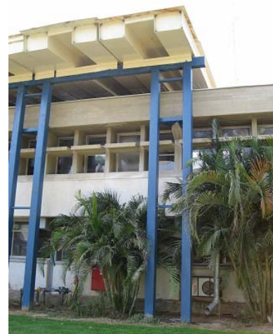
Die Klassenräume werden jetzt mit einer speziellen Stahlkonstruktion geschützt
