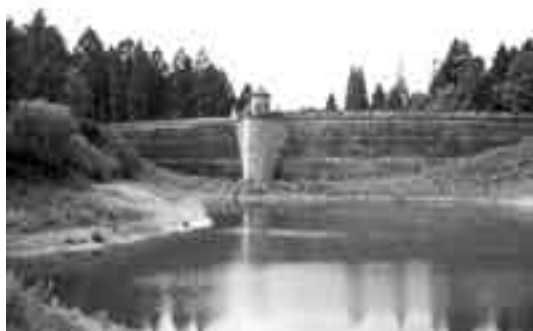
Fig.1 - Vê-se, aqui, o lado da água na barragem de alvenaria da represa de Ronsdorf, construída em 1898 pelo Prof. Intze, nas cercanias da cidade alemã de Wuppertal.
