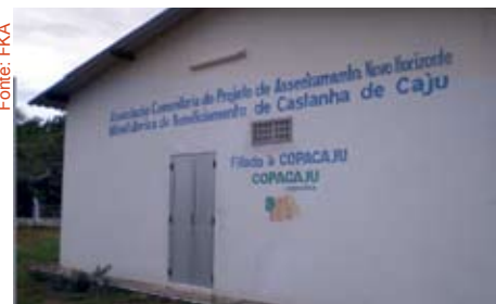
A Minifábrica de Beneficiamento de Castanha de Caju no Assentamento Novo Horizonte, Tururu
