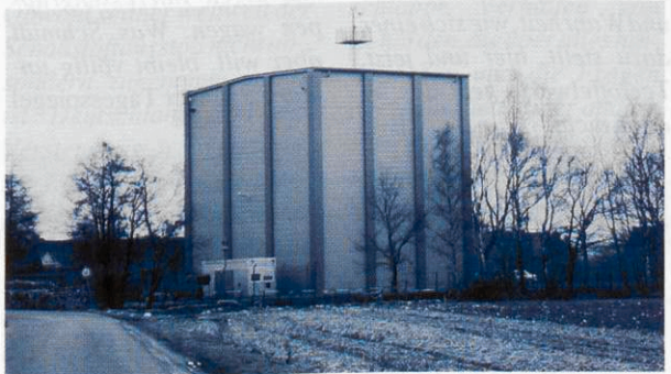
Früher forderten SPD und Grüne den Abriss aller Anlagen in Gorleben. Gerade rechtzeitig zum ersten rot-grünen Castortransport fertig: Die neue Halle für den Umladekran in Dannenberg zum Schutz vor Gewalttätären, auf Wunsch des SPD-Innenministers.
