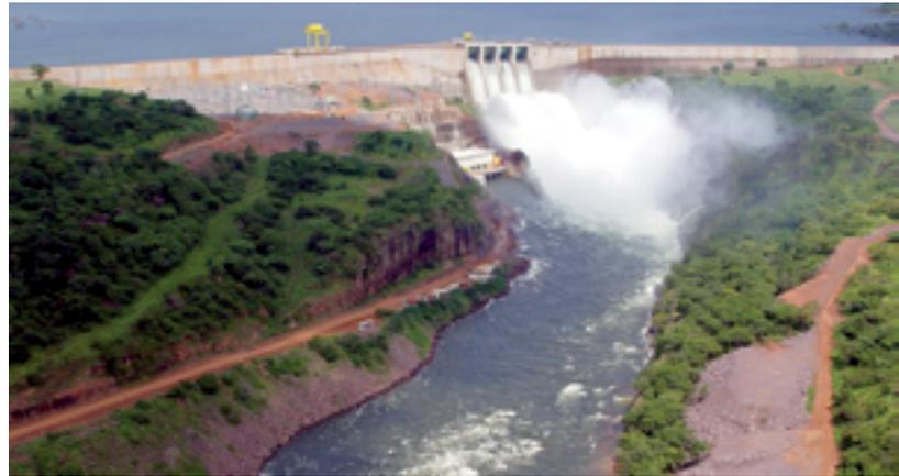
La presa de Capanda en el río Cuanza, en la provincia de Malanje tiene una capacidad de 520 megavatios con sus cuatro turbinas, cubriendo más de la mitad de la demanda energética de Angola.
