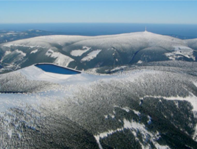
*La central hidráulica de bombeo Dlouhý Stráně es la más grande de la República Checa con una potencia máxima eléctrica en una central de régimen permanente de 650 megavatios. El depósito superior está a 1350 metros de altura.*
