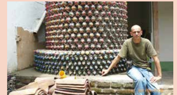
2000 l cisterna en obra gruesa ©Andreas Froese, www.eco-tecnologia.com
