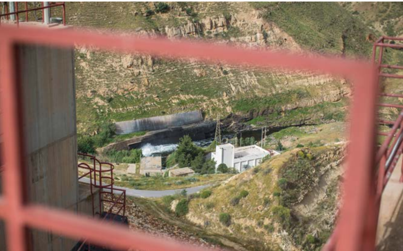
Mangelware Wasser: Der Ausbau der jordanischen Wasserinfrastruktur ist ein Schwerpunkt deutscher Entwicklungszusammenarbeit mit dem Königreich. Doch nach wie vor erreicht wegen technischer Mängel und Diebstahls überhaupt nur die Hälfte des produzierten Wassers die Endkunden. Im Bild ein Wasserwerk an der König-Talal-Talsperre. Foto: © Thomas Imo, photothek, picture alliance.
