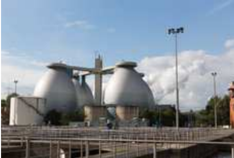
Kläranlage Bottrop. Foto: RIK / Guntram Walter
