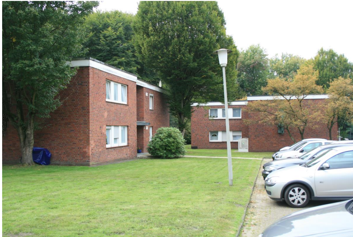
Baukörper vor dem Umbau
