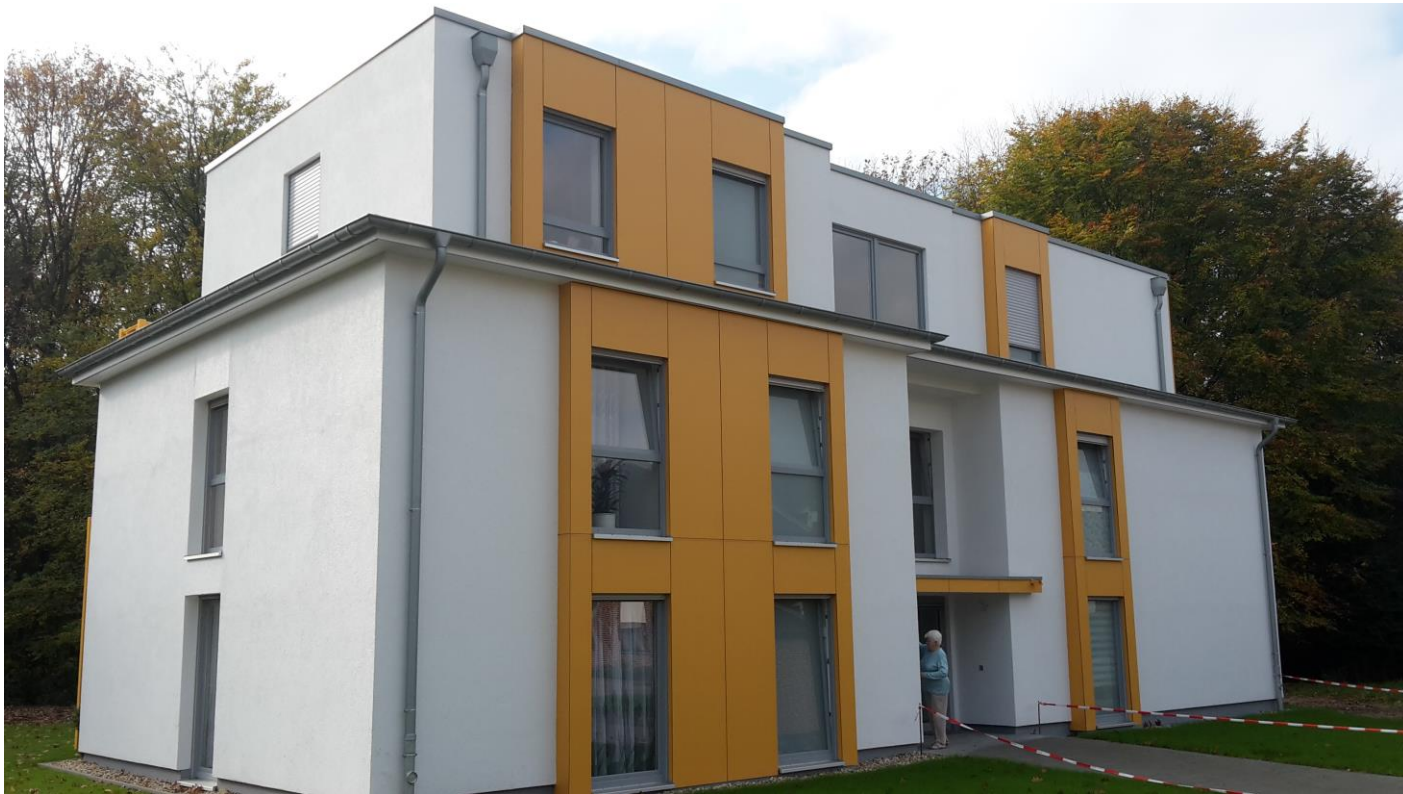
Baukörper mit neuer Fassade und aufgesetztem Staffelgeschoss
