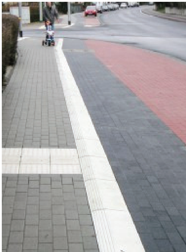
Bild 26: Trennstreifen von Railbeton
