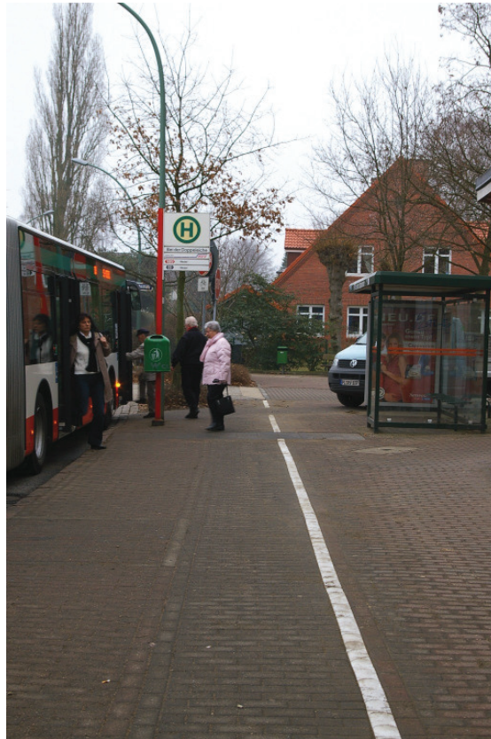
Bild 22: Geh- und Radweg-Trennung an einer Bushaltestelle in Wedel
