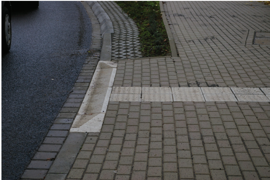
Bild 15: Kasseler Rollbord (Easycross)
