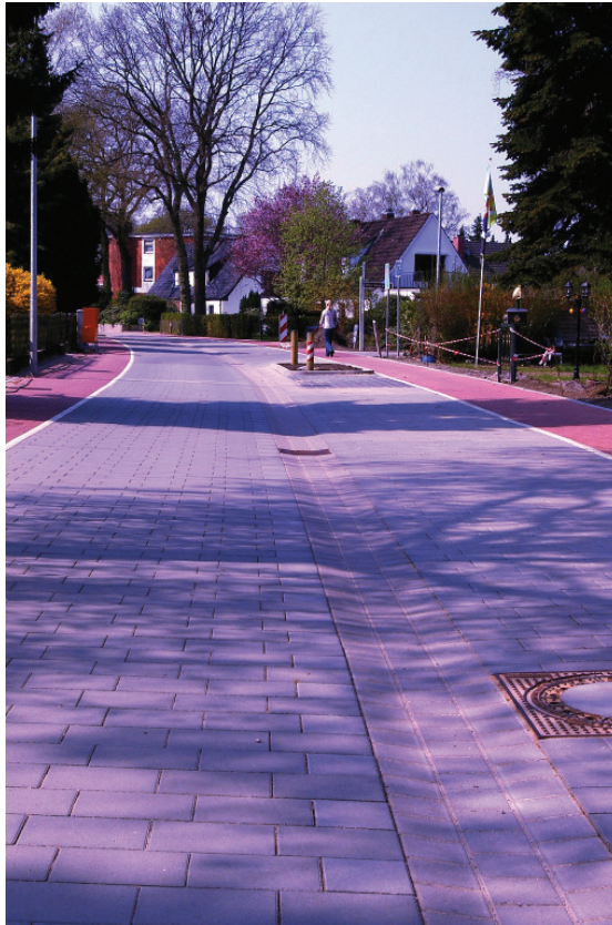
Bild 27: Trennsteine als Bordersatz in einer Anliegerstraße in Wedel
