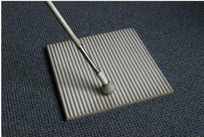
Bild 12: Bodenindikatoren mit 11 mm Abstand der Wellenberge
