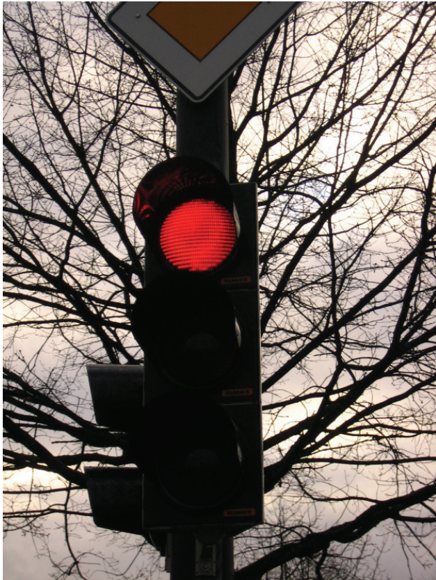
Bild 5: Lichtsignalanlage mit rotem Lichtzeichen
