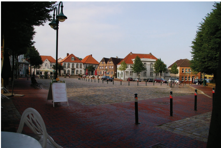
Bild 32: Natursteinpflaster mit planer Gehbahn in Meldorf
