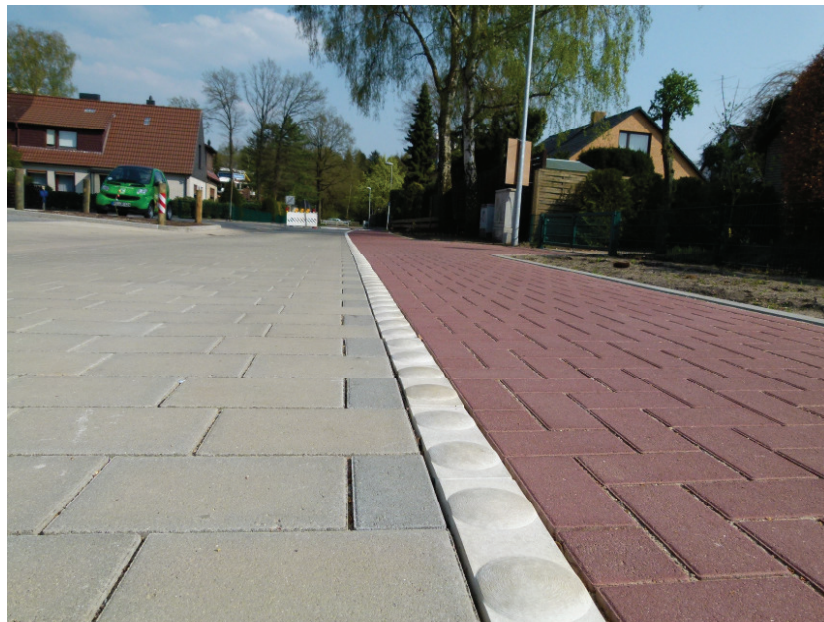
Bild 28: Großaufnahme des Trennstreifens zwischen Gehbahn und Fahrbahn
