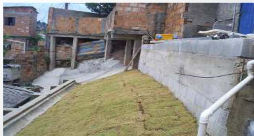
CONTENÇÃO DE ENCOSTAS
