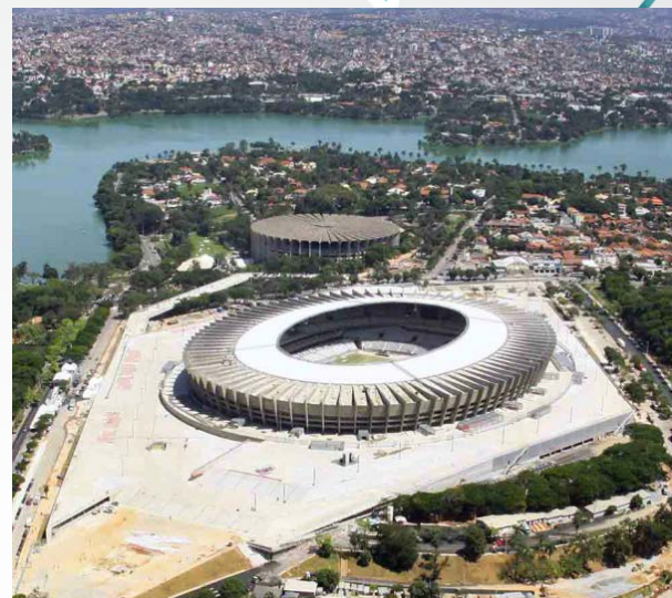
ENERGIA SOLAR FOTOVOLTÁICA
