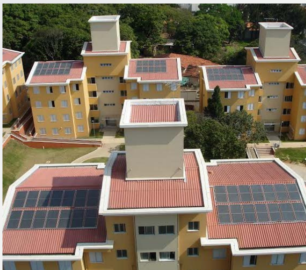
ENERGIA SOLAR TÉRMICA
