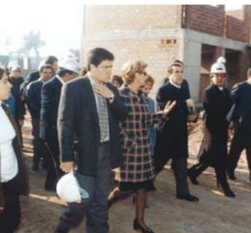
Visita a las obras de uno de los barrios de Eduardo Frei Ruiz Tagle, cuando era presidente de Chile.
