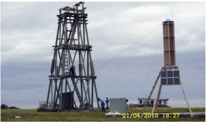
Челюскин мүйісіндегі маяк, Солтүстік Мұзды мұхит. Ресейдің жарық-маяк жүйесіне арналған фотоэлектр панельдермен біріктірілген Болотов роторлық жел турбинасы-2 КЭК-қа техникалық қызмет көрсету.
