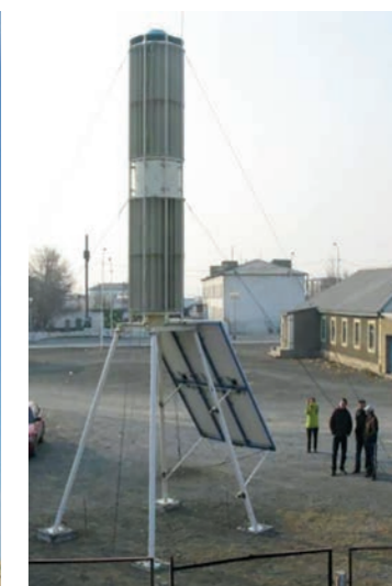
2006 жыл, Ажар кентіндегі «Қазақтелеком» АҚ объектісінде БРЖТ-2,6 КЭК, бір уақытта мектептің электрондық жабдығын, интернетті қоректендіруді қамтамасыз етеді.
