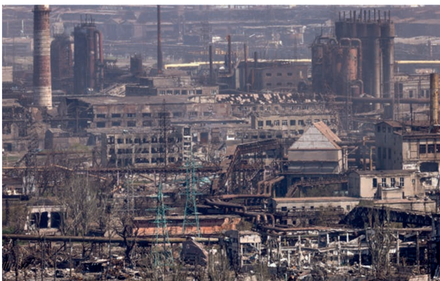
Фото 4. Металургійний завод «Азовсталь» (Маріуполь)
