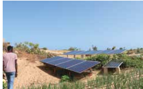
Mansour Diop, un jeune producteur vérifiant l'installation des dispositifs solaires
