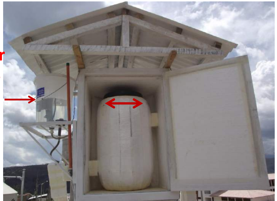
Tanque de almacenamiento de agua caliente en caseta
