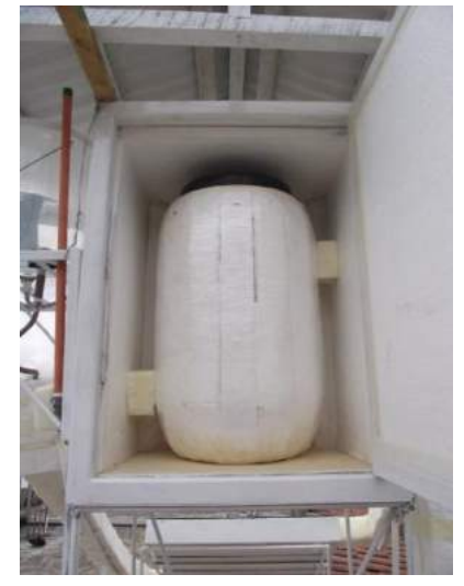
Tanque de almacenamiento de agua caliente en caseta
