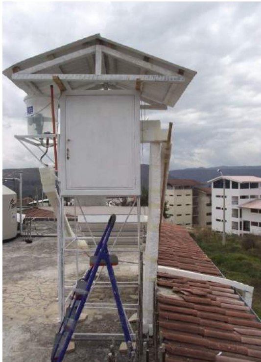
Tanque de almacenamiento de agua caliente en caseta
