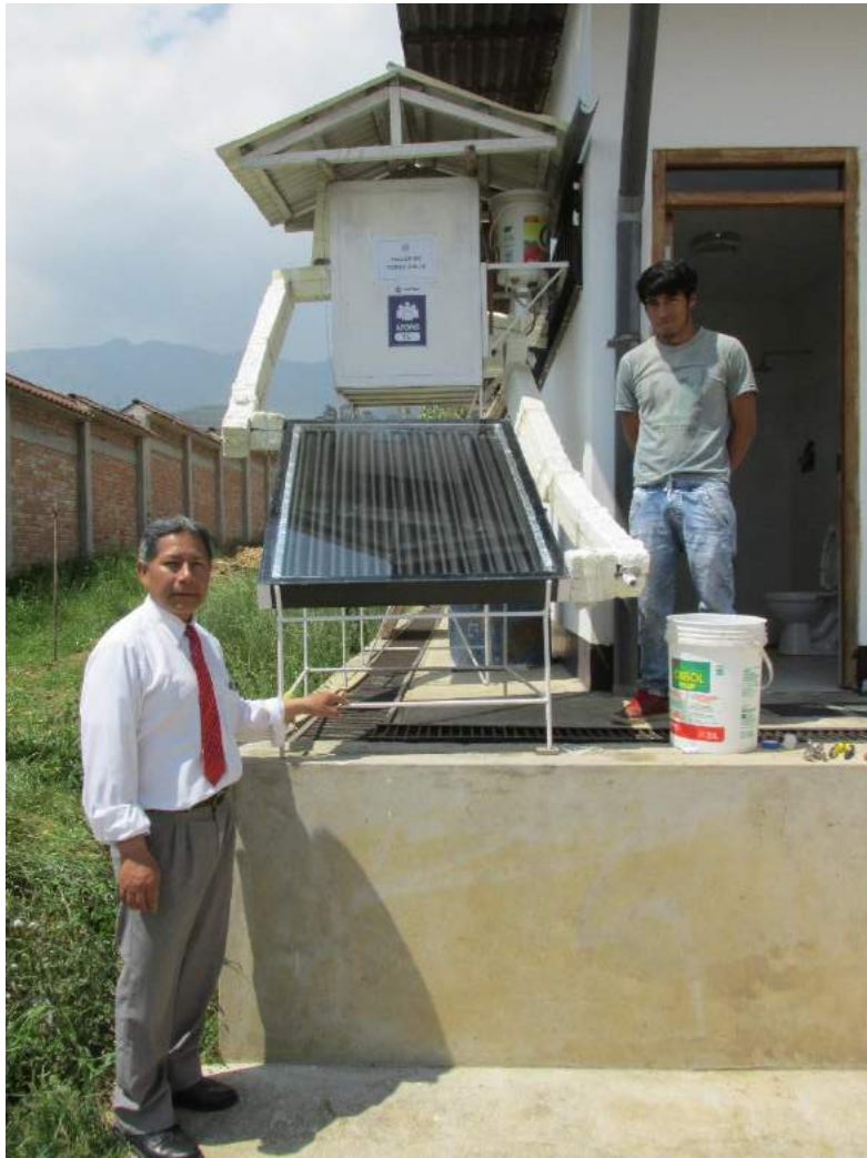
Terma solar instalada en el Establo de la UNTRM
