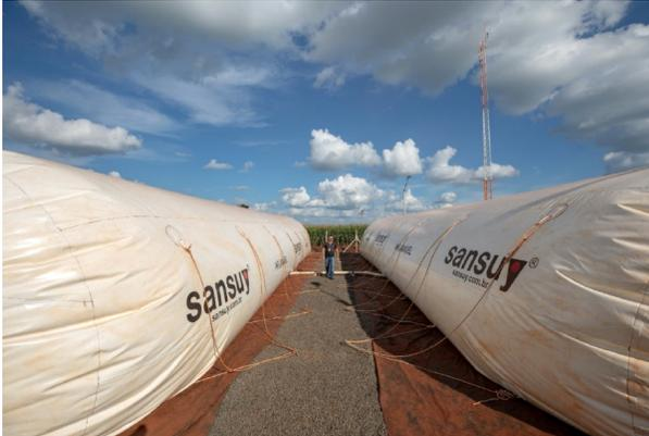
**Figura 7** - Detalles de los sistemas de almacenamiento de gas, en la unidad de generación de electricidad con biogás, en Entre Rios do Oeste. Fuente: CIBIOGÁS (2020)
