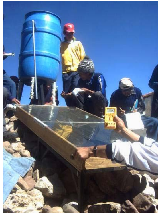
Yachachiqs realizando Pruebas experimentales de una terma solar
