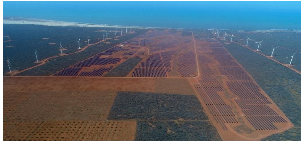
UFV de 101 MWp em Areia Branca (RN).
