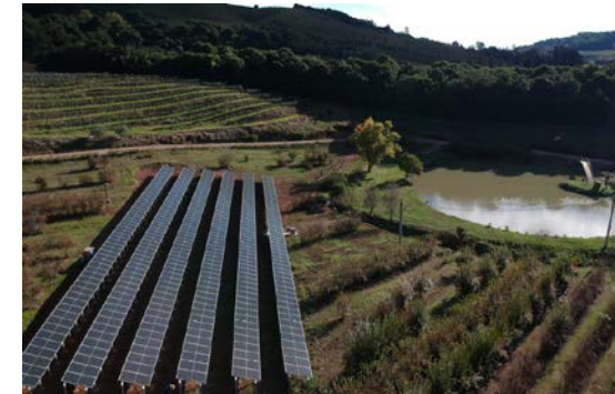
Sistema de solo em propriedade rural vinícola, Pinto Bandeira (RS).
