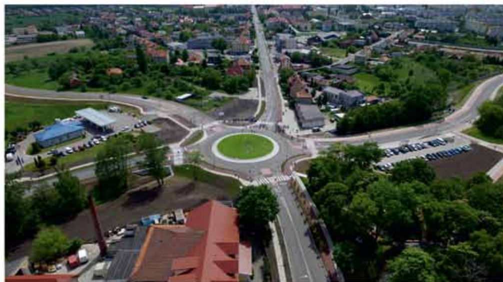
Budowa nowego układu komunikacyjnego skrzyżowania
