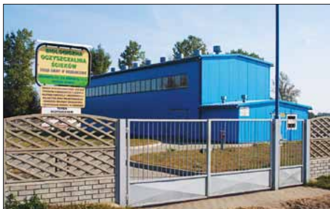
W 2000 r. w Grzegorzewie uruchomiono oczyszczalnię ścieków.
