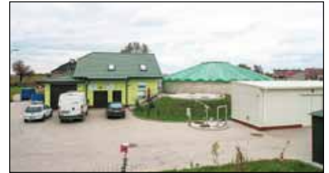
Samorzady rozwinęły systemy wodociągowe i kanalizacyjne m.in. dzięki budowie oczyszczalni ścieków.
