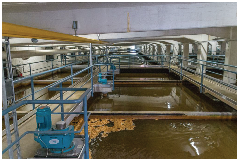
Слика 4.3: Миксери за мешање во флокулациски базени
