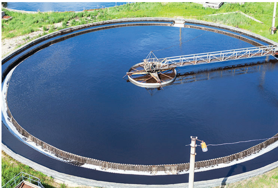
Слика 4.6: Кружен седиментациски базен
