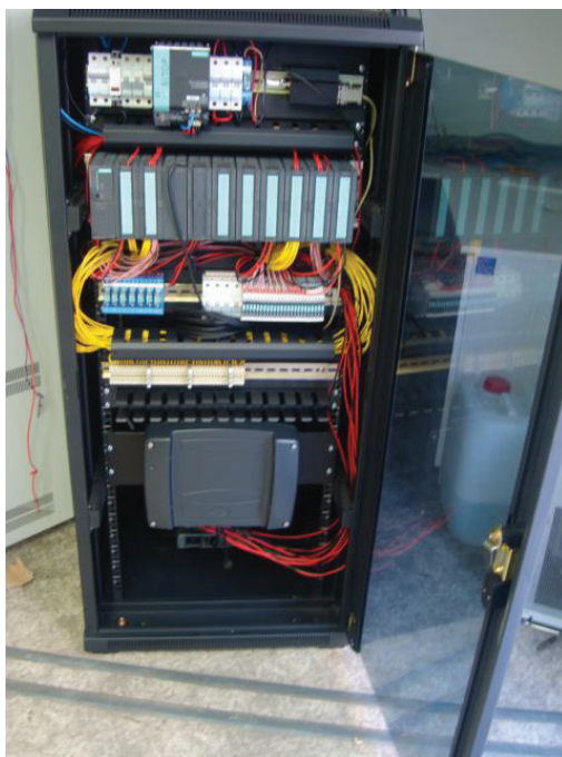
Слика 6.5: Локална мониторинг станица автоматизирана со PLC
