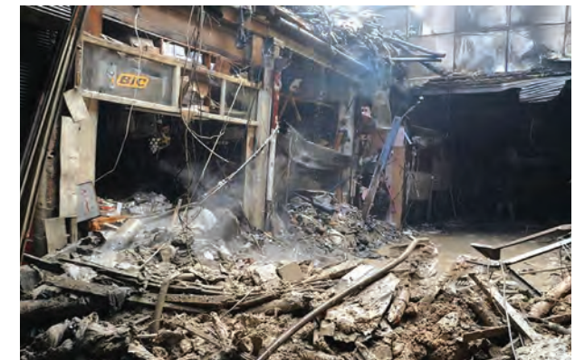
Brandschäden nach dem Feuer auf dem Damaszenzer Asruniya-Markt
