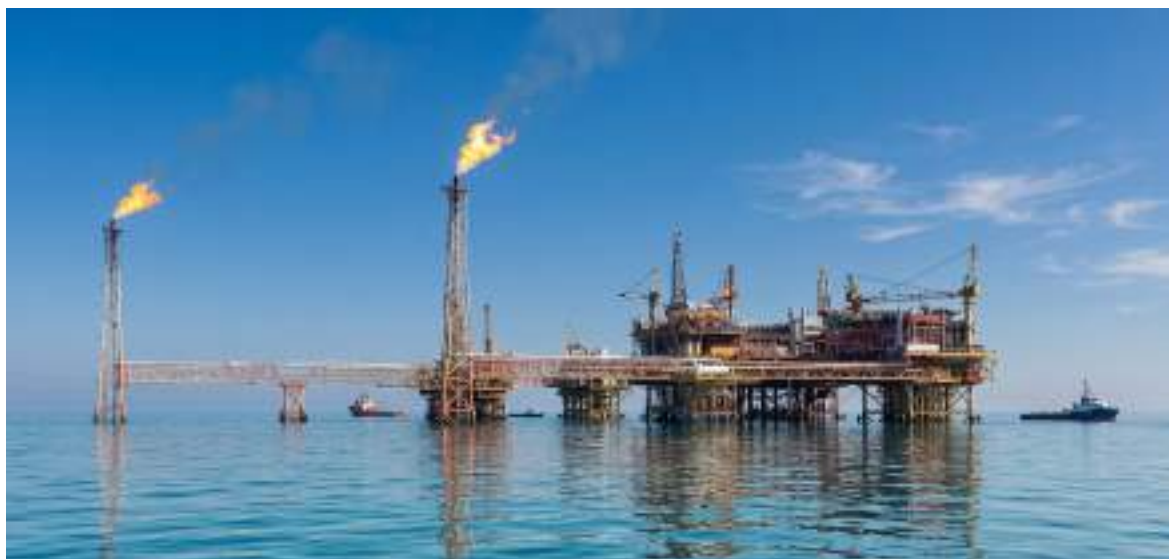
Instalación del Complejo Cantarell en el golfo de México
