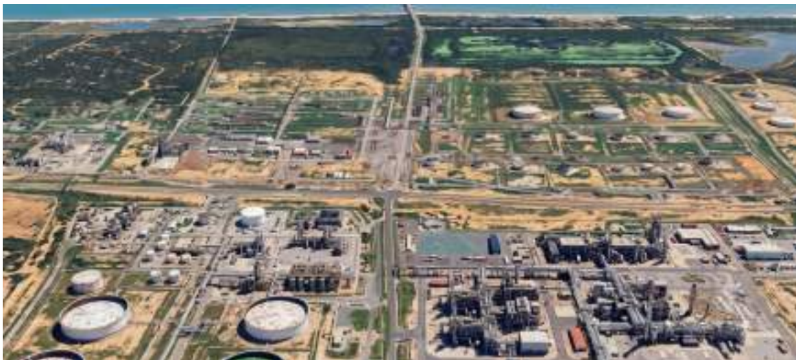
Complejo Petroquímico de Jose, Anzoátegui en Venezuela (Vista aérea)
