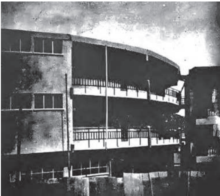
Infraestructura en construcción del Liceo Dora Smith de La Paz (1977). Fuente: Ministerio de Educación, Historia de la Educación en Bolivia a través de las Memorias del Ministerio de Educación, Tomo VIII, p. 557.
