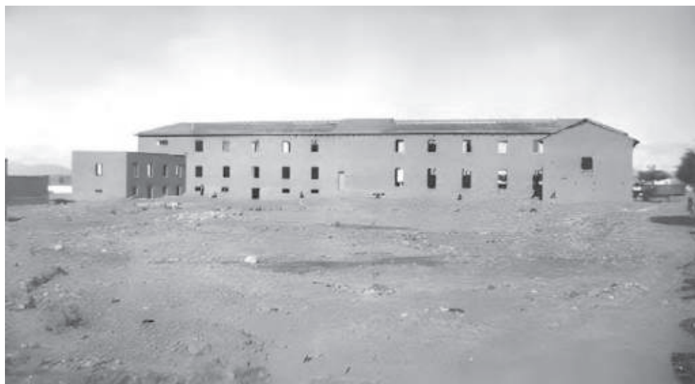
Pabellón en construcción de la escuela de Warisata (1940).
