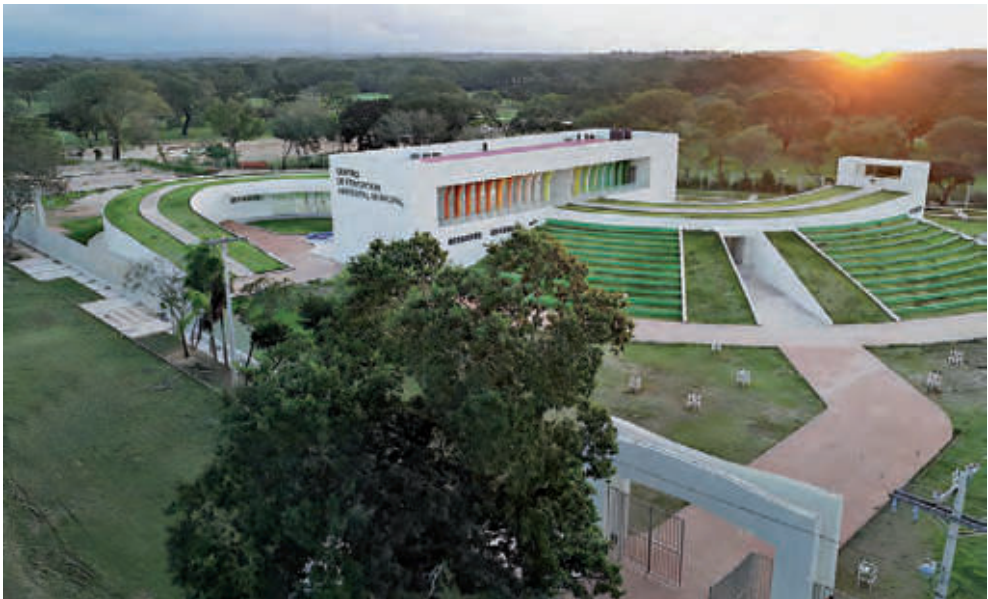
Centro de Educación Ambiental Municipal de la ciudad de Santa Cruz de la Sierra. Fuente: Página web del Gobierno Autónomo Municipal de Santa Cruz de la Sierra.
