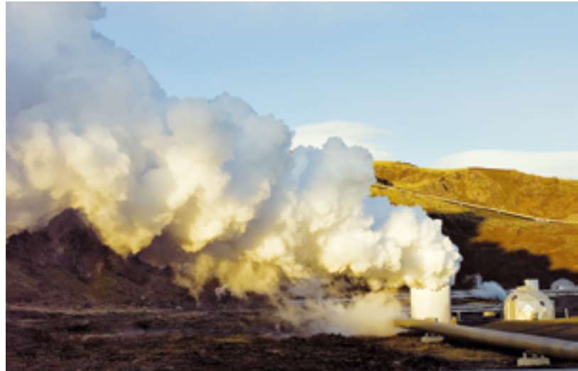
Ein Geothermiekraftwerk in Olkaria. Kenia erzeugt mit drei Kraftwerken dieser Art 200 Megawatt und ist das erste Land Afrikas, das Erdwärme als Energiequelle nutzt.
